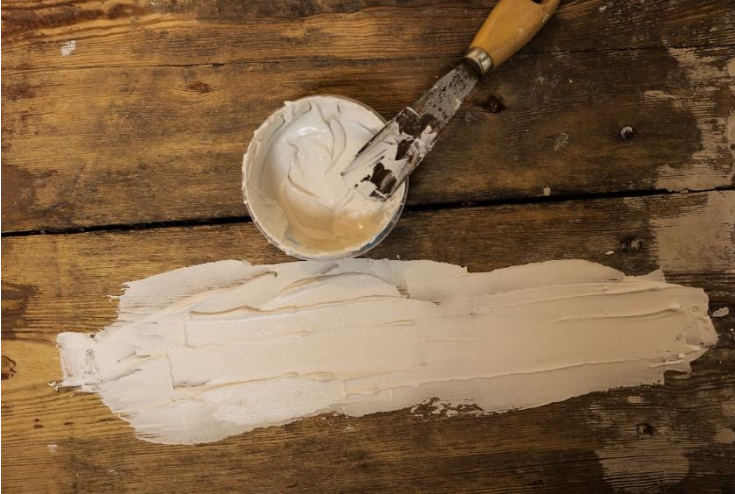
Şekil 6: Dolgu macunu ile ahşap malzeme onarım uygulaması (Web 10, 2022).
