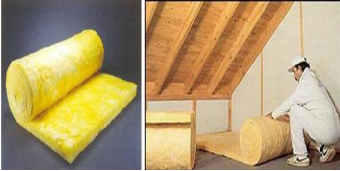
Şekil 3. Isıtılmayan Bir Çatı Arasında Cam Yünü Isı Yalıtım Ürününün Döşemeye Serilmesini Göstermektedir (Aydın, 2010).
