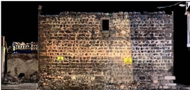
Şekil 2.16 Batı cephesi (3d lazer tarama verisi)
