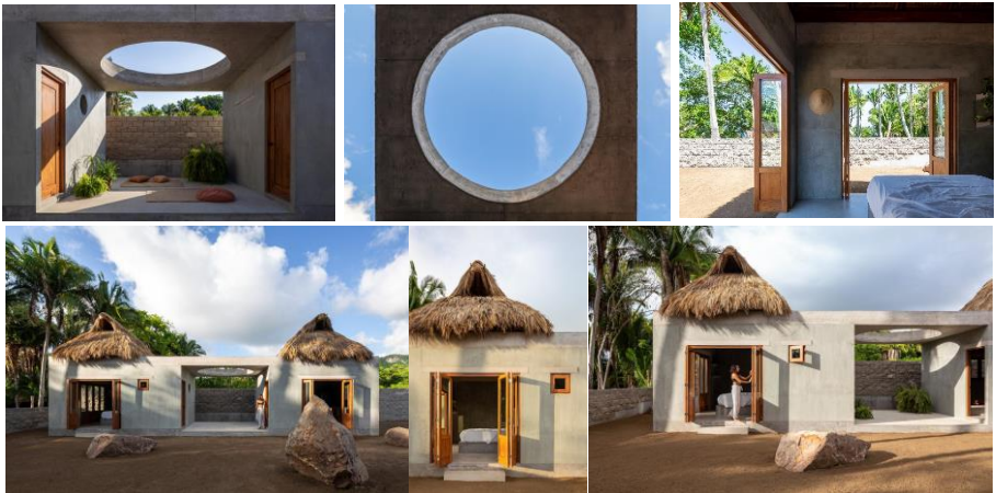
Görsel 15: Litibú Bungalow Dış Cephe [URL-8]
