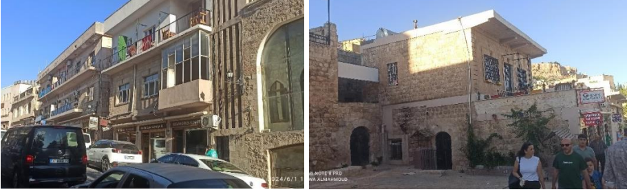
Şekil 3 Betonarme ile restore edilen taş binalar (Gouran Hasan,2024)
