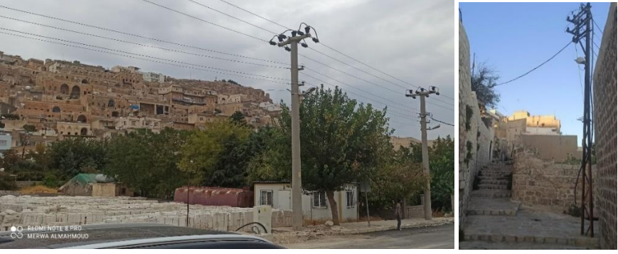
Şekil 16 Eski şehirde elektrik direkleri (Gouran Hasan,2024)
