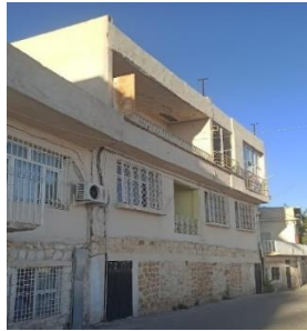
Şekil 8 Şehrin üst kısmındaki beton binalar (Gouran Hasan,2024)
