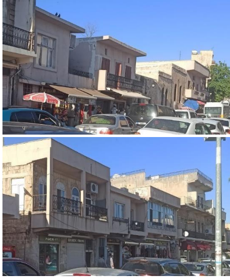
Şekil 9 Kentsel çevreye uyacak şekilde değiştirilmiş beton bina cepheleri (Gouran Hasan,2024)
