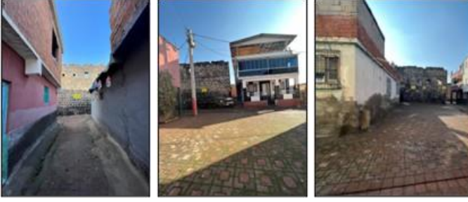
Şekil 2.15 Doğu ve Kuzey cephesinde ve Parsel içinde yer alan muhdes yapı
