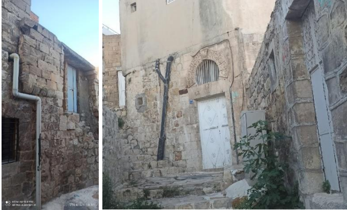
Şekil 17 Taş cephelerde sıhhi tesisatlar (Gouran Hasan,2024)
