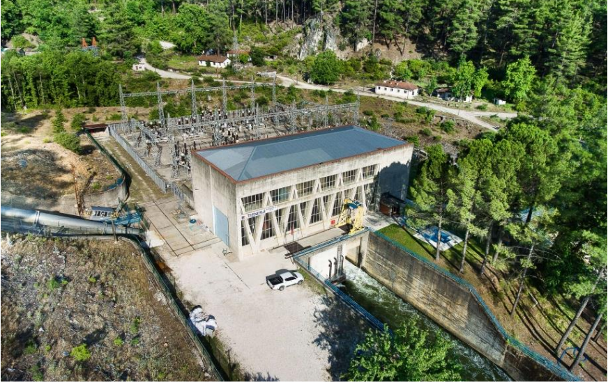
Şekil 8. Kovada II Hidroelektrik Santrali (Batienerji, 2024)
