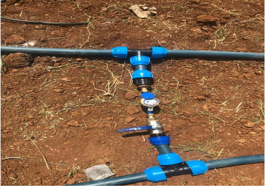
Şekil 3.13. Araştırmada kurulan sayaç sistemi
