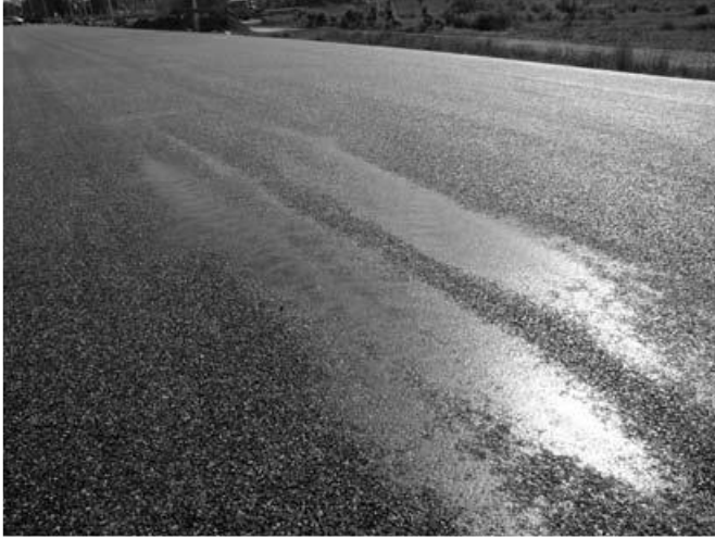
Şekil 3. Bağlayıcıda boylamasına yağ lekeleri.
