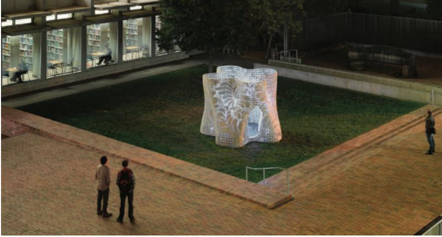
Şekil 7. Bloom, 3B baskı ile üretilmiş Portland çimentosu kullanılarak deneysel amaçlarla yapılan bir pavilyon (Rael ve Fratello, 2018).
