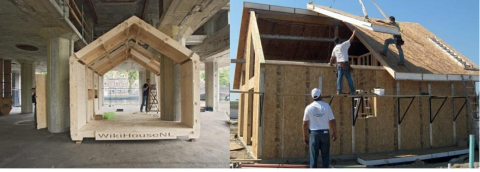
Şekil 19. Açık kaynak evlerinde yerinde montaj uygulamaları (Wikihouse, 2019)
