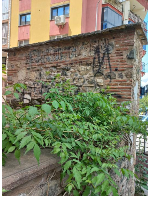
Resim 17: Dokur Çeşme Arka Cephe ve Depo Birimi
