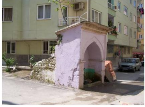
Resim 26: 1999 Kaynak Mahallesi Çeşmesi Ön Cephe Kaynak: Hasan Uçar
