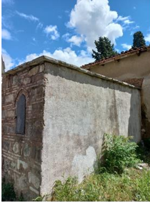
Resim 9: Lalapaşa Mahallesi Çeşmesi Arka Cephe Kaynak: Yazar tarafından oluşturulmuştur.
