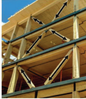
Şekil 1.7. GLULAM kiriş uygulama [38].
