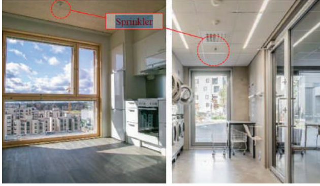
Şekil 12.17. Hoas Tuuliniity yapısında sprinkler sistemin konumu [6]
