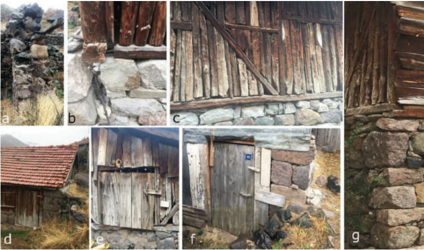
Şekil 16.5. Samanlıkların konstrüksiyon detayları
