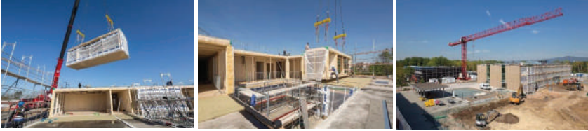
Şekil 4.33. Ahşap hücre sistemle genişletilen okul binası, Frankfurt, Almanya [80]
