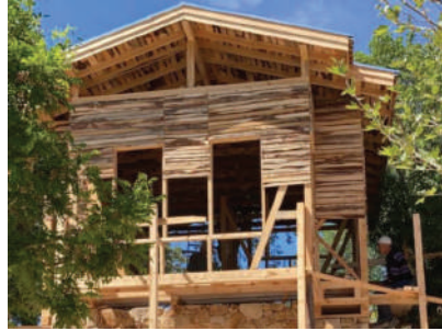
Şekil 8.5. Şamdolma duvar örneği [6]
