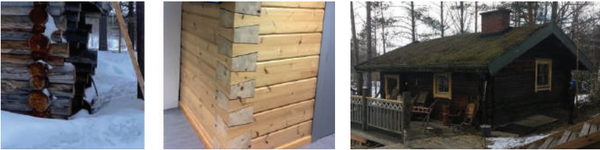
Şekil 4.3. a) Eski köşe detayı b) Modern köşe detayı [12] c) Kütük ev [13]
