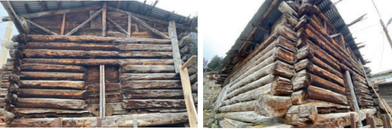
Şekil 14.15. Ahşap yığma yapım teknikli duvarlara sahip yapı örnekleri [43]
