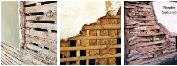
Şekil 10.5. Dal örgü tekniği ile inşa edilmiş duvarlar (Türkiye, Güney Kore ve İngiltere) [47, 52, 53]
