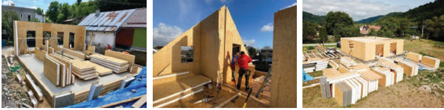
Şekil 4.31. Yapısal yalıtımlı panel sistem inşası [78]
