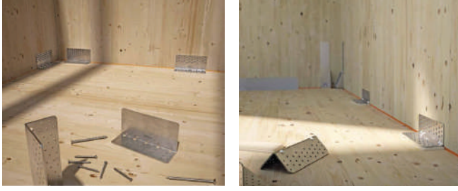
Şekil 7.7. Ahşap panel ve zemin bağlantısı [47].
