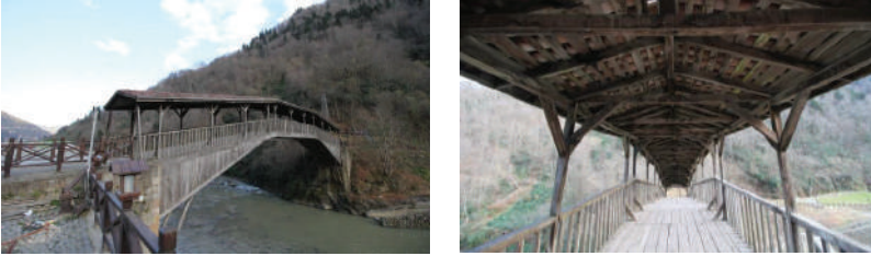
Şekil 14.7. Doğu Karadeniz kırsal mimarisi ahşap köprü örneği [39]
