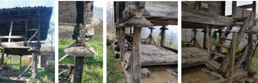
Şekil 14.14. Serender ve konstrüksiyon detayları
