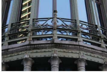
Ŗekil 17.6. Süs elemanı demir malzeme [7]
