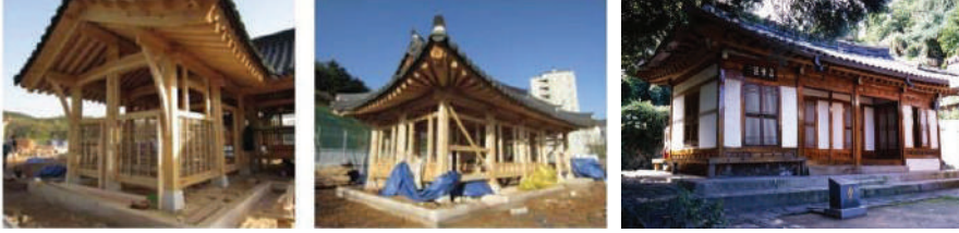
Şekil 4.8. Geleneksel ahşap Hanok Evi yapımı [17, 19]
