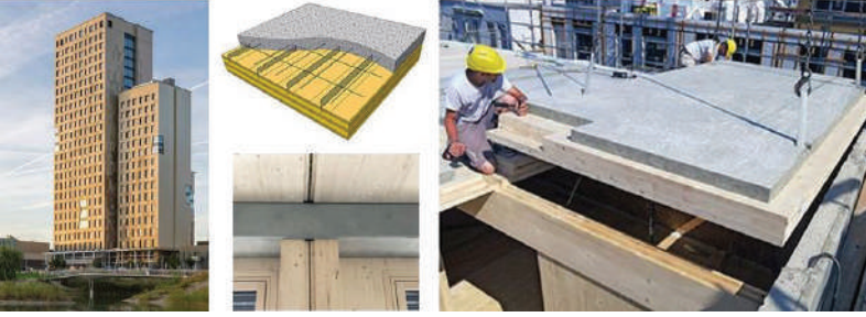
Şekil 12.9. Hoho Wien yapısı ve strüktürel kurgu [18]
