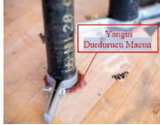
Şekil 12.5. Origine yapısında yangın durdurucu macun uygulaması [6]
