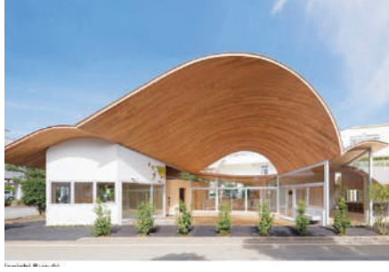
Şekil 1.5. LVL'nin yapıda kullanımı [30].
