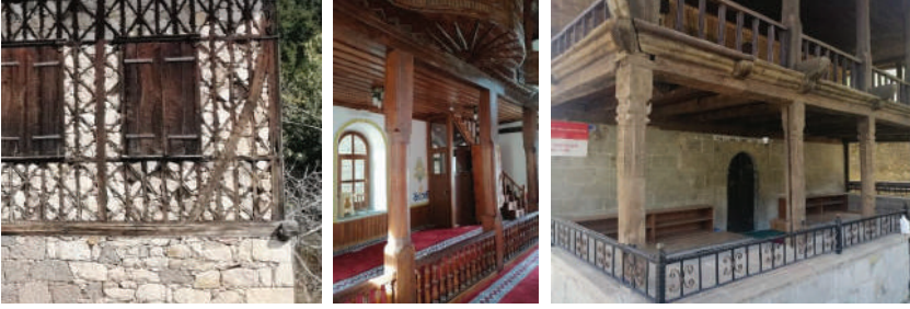
Şekil 14.13. Ahşap taşıyıcı sisteminden örnekler
