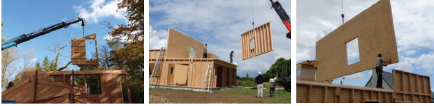
Şekil 4.30. Ahşap taşıyıcı panel sistem inşası [77]
