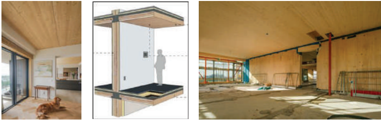
Şekil 12.12 a. Haut yapısının açıkta kalan ve kaplanmış strüktürü (1.ve 2.şekil) [20] b. Açıkta kalan ahşap tavanların korunması (3.şekil) [20]
