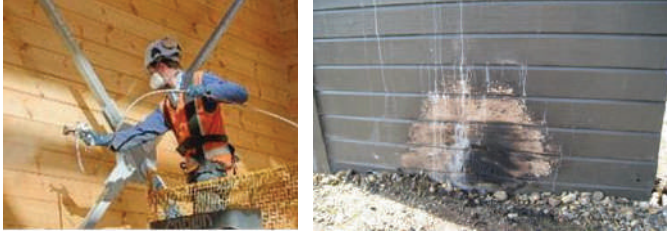
Şekil 12.4. Ahşap yüzeye yangın geciktirici kaplama uygulaması [9]
