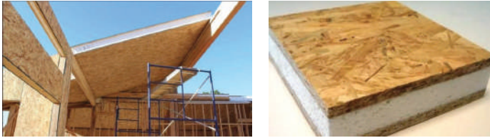
Şekil 1.14. Ahşap sandviç panel uygulaması [70]
