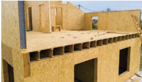
Şekil 1.15. OSB panel uygulaması [78]
