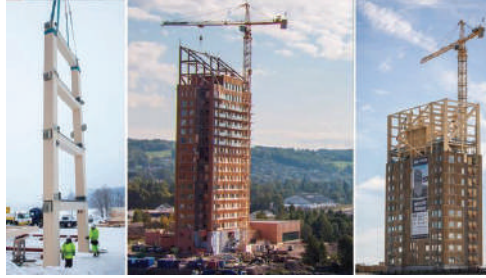
Şekil 12.7. Mjostårnet yapısı inşa aşaması [15]
