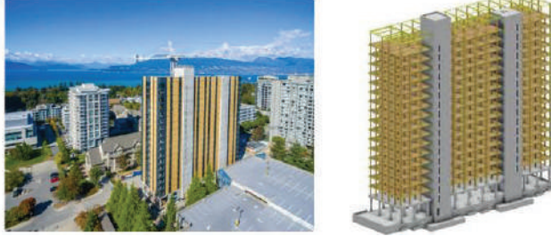
Şekil 12.13. Brock Commons yapısı ve hibrit strüktür kurgusu [1,21]
